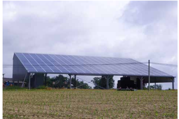
Frankreich, Saint-Cricq-Chalosse, 100 kWp
